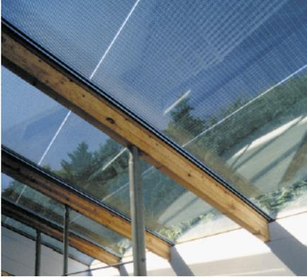
COBERTURA ENVIDRAÇADA COM MÓDULOS FOTOVOLTAICOS SEMITRANSSPARENTES DE PELÍCULA FINA
