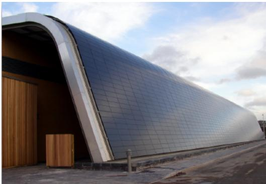
MÓDULOS FOTOVOLTAICOS ARQUITECTONICAMENTE INTEGRADOS NA COBERTURA DO EDIFÍCIO DA AGÊNCIA DE DESENVOLVIMENTO ESCOCESA
